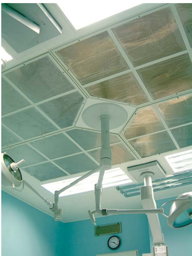
Рисунок 2. Установки «Поток» с воздухораспределителем в операционной ГКБ им. С. П. Боткина, г. Москва.
